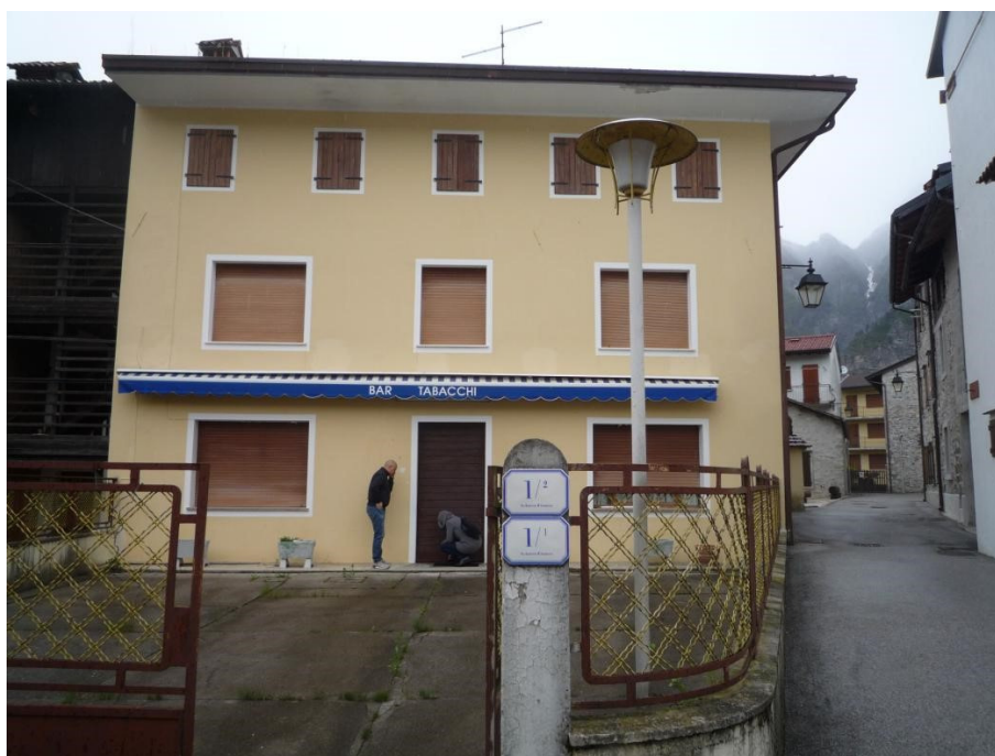
Vista dell'accesso principale al fabbricato da via Gabriele d'Annunzio
